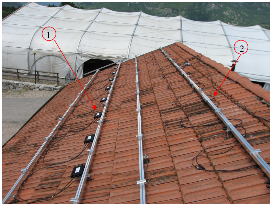
Particolare dell'impianto che mostra del due tipologie di sgancio dei pannelli fotovoltaici
